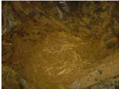
土と砂をまぜたら、ひび割れ予防にわらも入れる
