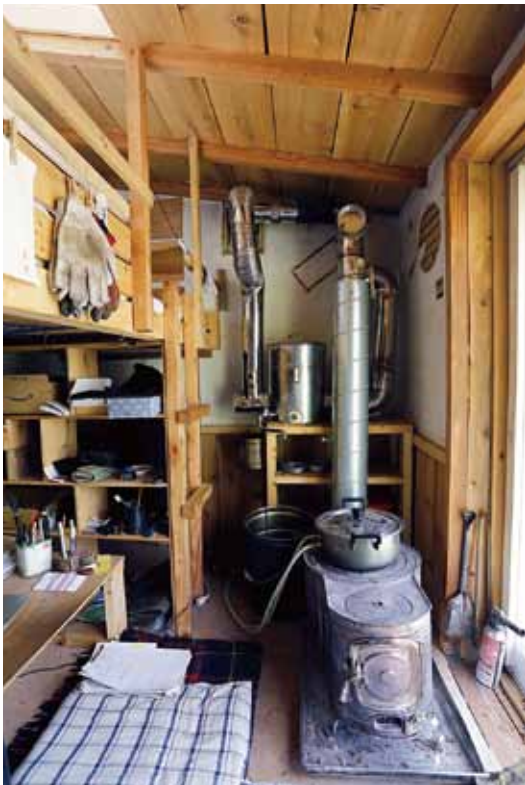
時計型の薪ストーブを改造したもの。仕組みと構造は割愛するが、これは暖房であり、調理具であり、給湯器であり、床暖の熱源でもある。
