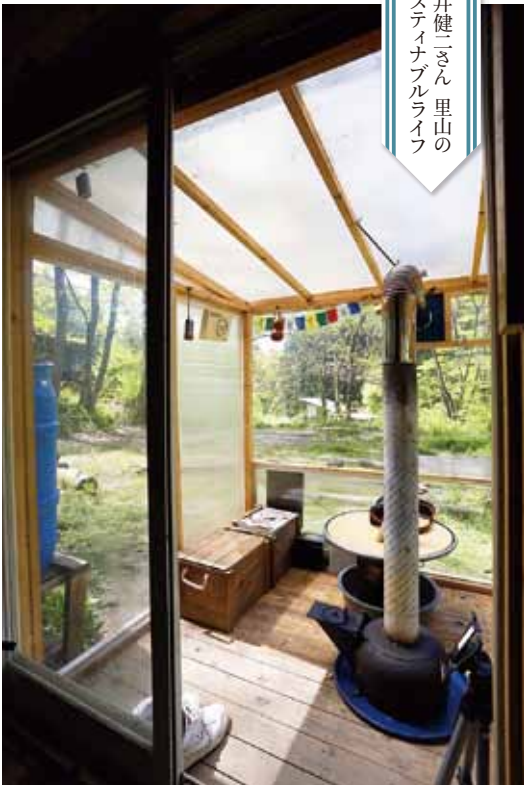
モバイルハウスのサンルームには排油を燃料とするストーブが。こちらは二次燃焼させて空気の引き込みを良くするよう、改良が成されている。
