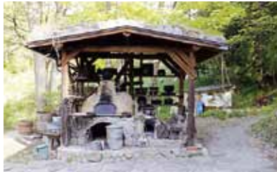
薪をくべると、登り窯のように、下段、上段を温める。薪のシステムキッチンだ。
