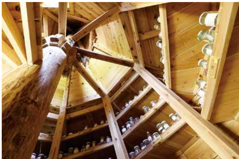
2012年、パーマカルチャー塾の受講者が建てた『種センター』。内部は螺旋状になっており、棚には瓶に入ったタネが。産廃の量が断熱材として使い、建物内の温度変化を抑えている。デザインも参加者全員で考えた。
