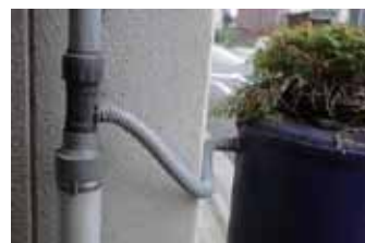
樋の長さを調節して「天水尊」に繋げる。家族で取り付ければ雨が降るのが楽しみになる？
