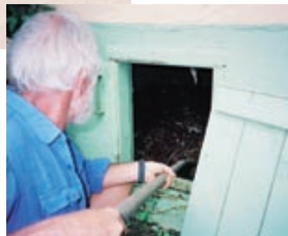
▼堆肥トイレの下は小さな部屋になっていて、ミミズとだんご虫が分解してくれる。
