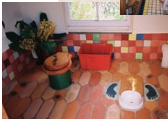
▼まったく臭わない快適な堆肥トイレ。洋式、和式、好きな方を使う。床や壁には地元のタイル工場で捨てられたタイルを使っている。
