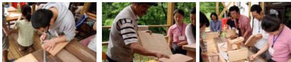
①座面の角4かに墨付けして、鋸で切れます。墨付けは、表面と側面の両方です。
