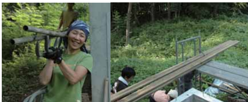
足場を組みます。
