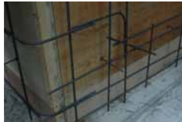
鉄筋が組みあがったので外の型枠を作る作業に取りかかりました。あと半日あれば組あがりそうです。
