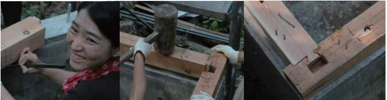
4本全ての土台に、穴を開けたら、いよいよ土台を設置していきます。アリの部分がぴったりはまりました!手違いにより?はまらなかったところは、国王こと小杉棟梁がその部分を切り落とし、調整してもらいました。
