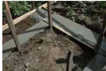
半分余の計算だったので、取り出し口にも土間を打ちました。2日ほどして基礎の側面型枠作りに入ります。
