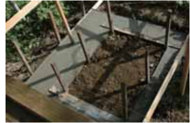
半分余の計算だったので、取り出し口にも土間を打ちました。2日ほどして基礎の側面型枠作りに入ります。
