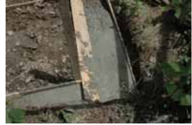
7月5日トイレのベース打ち。
