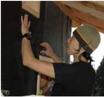
外壁下地作り・地道な作業です。
