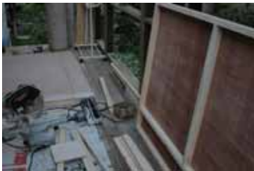
7月19・20日外部型枠の積み立て せばの部分たたき印を付けて穴を空けて組み立てました。ソーラチムニーの部分のボイド管を取り付ければ完了です。後はコンクリートを打てば完了です。
