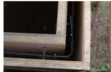
7月19・20日外部型枠の積み立て せばの部分たたき印を付けて穴を空けて組み立てました。ソーラチムニーの部分のボイド管を取り付ければ完了です。後はコンクリートを打てば完了です。
