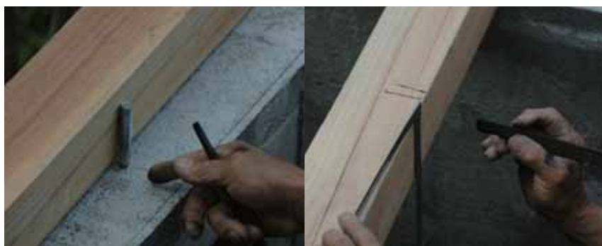
アンカーボルトがと土台にはまるようにきちんと計る。
