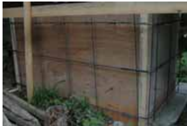
鉄筋が組みあがったので外の型枠を作る作業に取りかかりました。あと半日あれば組あがりそうです。
