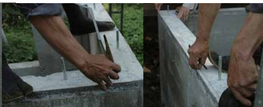
コンクリートに、土台を置く場所を墨壺で墨を打っていきます。
