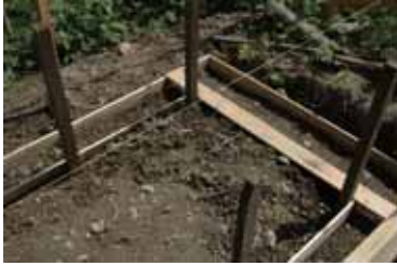
6月28日 トイレの基礎の型枠を作る。
