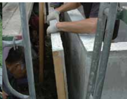
残っていた型枠をはずします。
