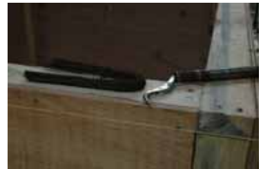
7月18日鉄筋を切って組み立てました。結束線を使ってハッカーで結束していきます。鉄筋工事:捨てコンクリートを打った後、その上に基礎幅を出していきます。(墨出しと言います) その墨にあわせて、鉄筋を組んでいきます。鉄筋は、結束線といわれる鉄の細い線で結んで固定をしていきます。結束線を結ぶときには「ハッカー」といわれる道具を使います
