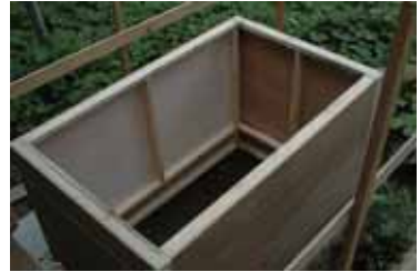
7月13日ベースの型枠をはずして、ベースの上に型枠を作り、12センチの丸せばを取り付けました。
