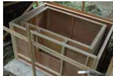
7月19・20日外部型枠の積み立て せばの部分たたき印を付けて穴を空けて組み立てました。ソーラチムニーの部分のボイド管を取り付ければ完了です。後はコンクリートを打てば完了です。
